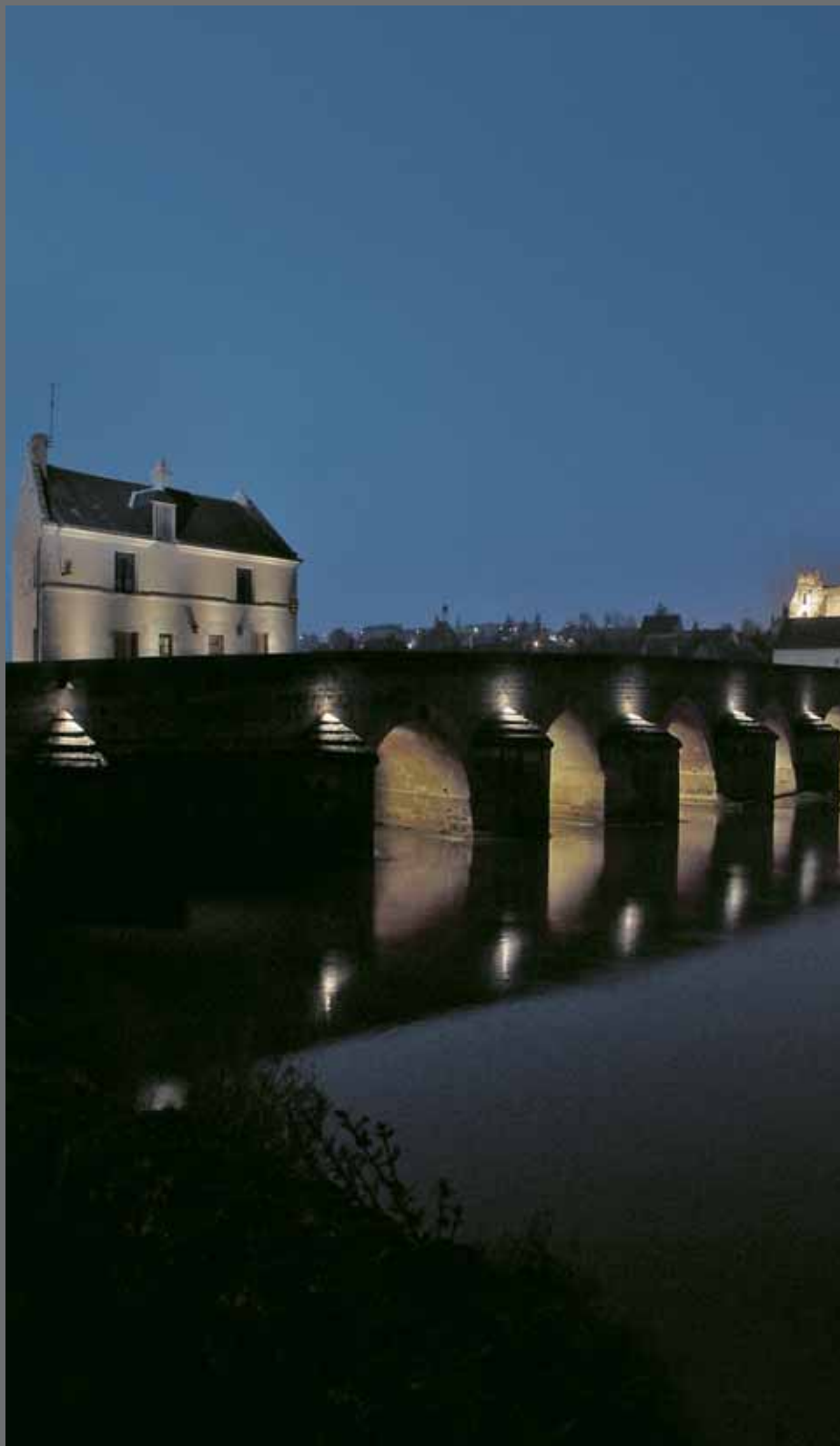
Maison du Passeur du Pont de Montrichard
